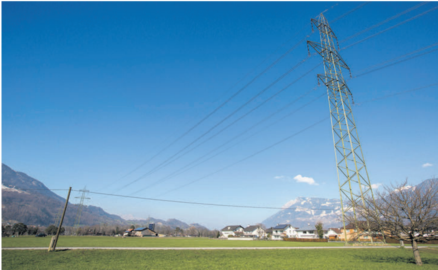
Der Gemeinderat kann nun über die möglichen Varianten zur Verlegung der Leitung diskutieren.
